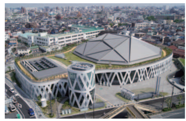
大田区総合体育館
